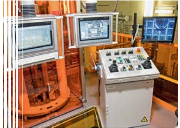
Ausführung der Bedienplattform nach der Ertüchtigung der Lademaschine
