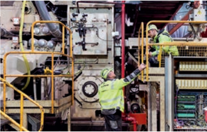
Service-Einsatz bei Finsa, Brasilien
